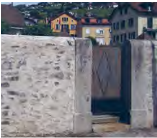
Réfection des murs de vigne à Lavaux (en page 8)
